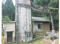
JA鳥取中央の山守発電所。水利権はJA、京東電力が施設建設で地権者がJAが運営する形になった。(鳥取県鳥取市)
